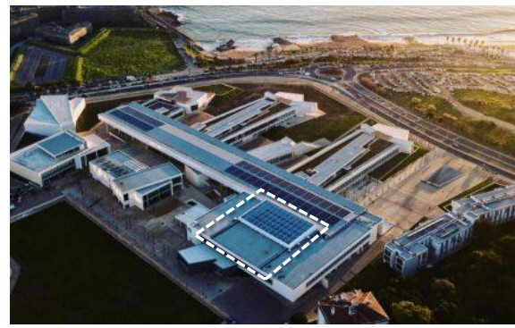
b) Edifício acabado (zona de intervenção assinalada)
