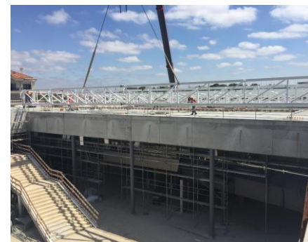
c) Montagem faseada no local
