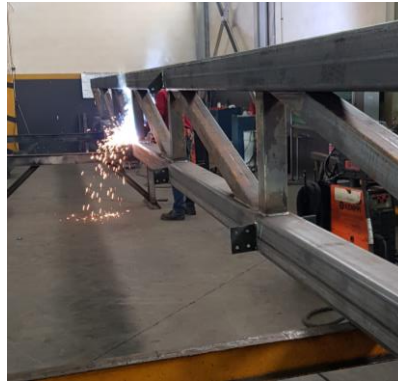
b) Armação e soldadura das treliças principais
