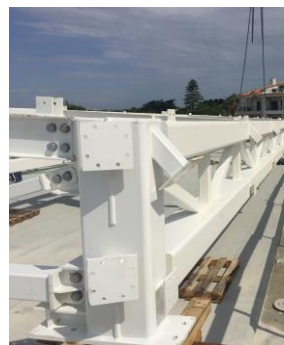
b) Pré-montagem das vigas treliça das claraboias
