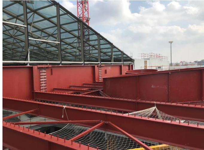
b) Compatibilização da fachada cortina de vidro com a estrutura metálica
