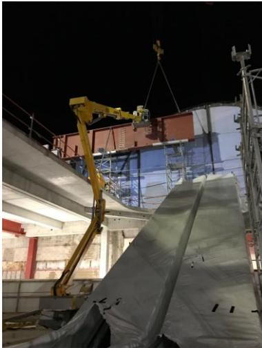
a) Compatibilização da montagem da estrutura metálica com os meios de elevação e os equipamentos já montados.
