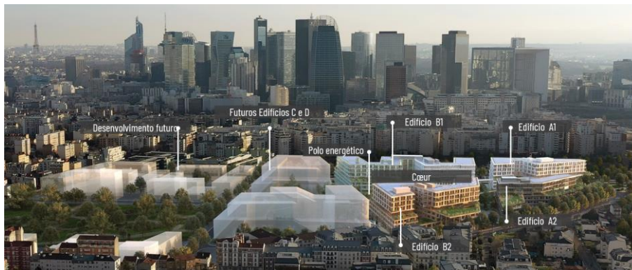
Fig. 2: Enquadramento do Campus Engie (fonte: adaptado de projeto de arquitetura [1]).
