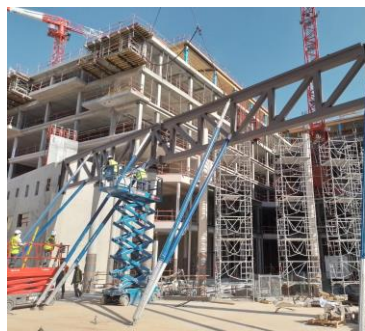
b) Estabilização da treliça TR1
