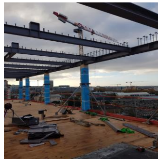
e) Montagem da estrutura metálica na cobertura de um dos edifícios
