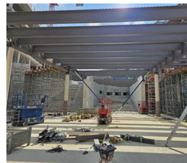
c) Montagem das vigas do “Coeur”
