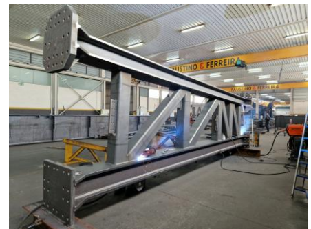
c) Soldadura da treliça TR2 do “Coeur”
